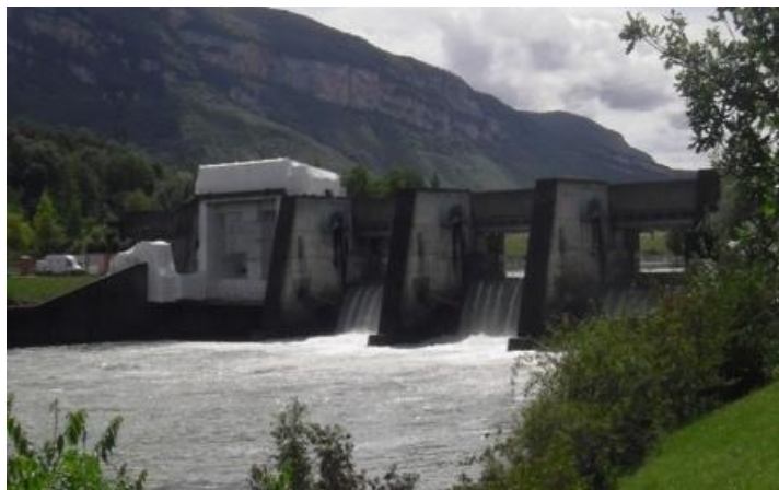
Barrage de Sault-Brénaz (01)
